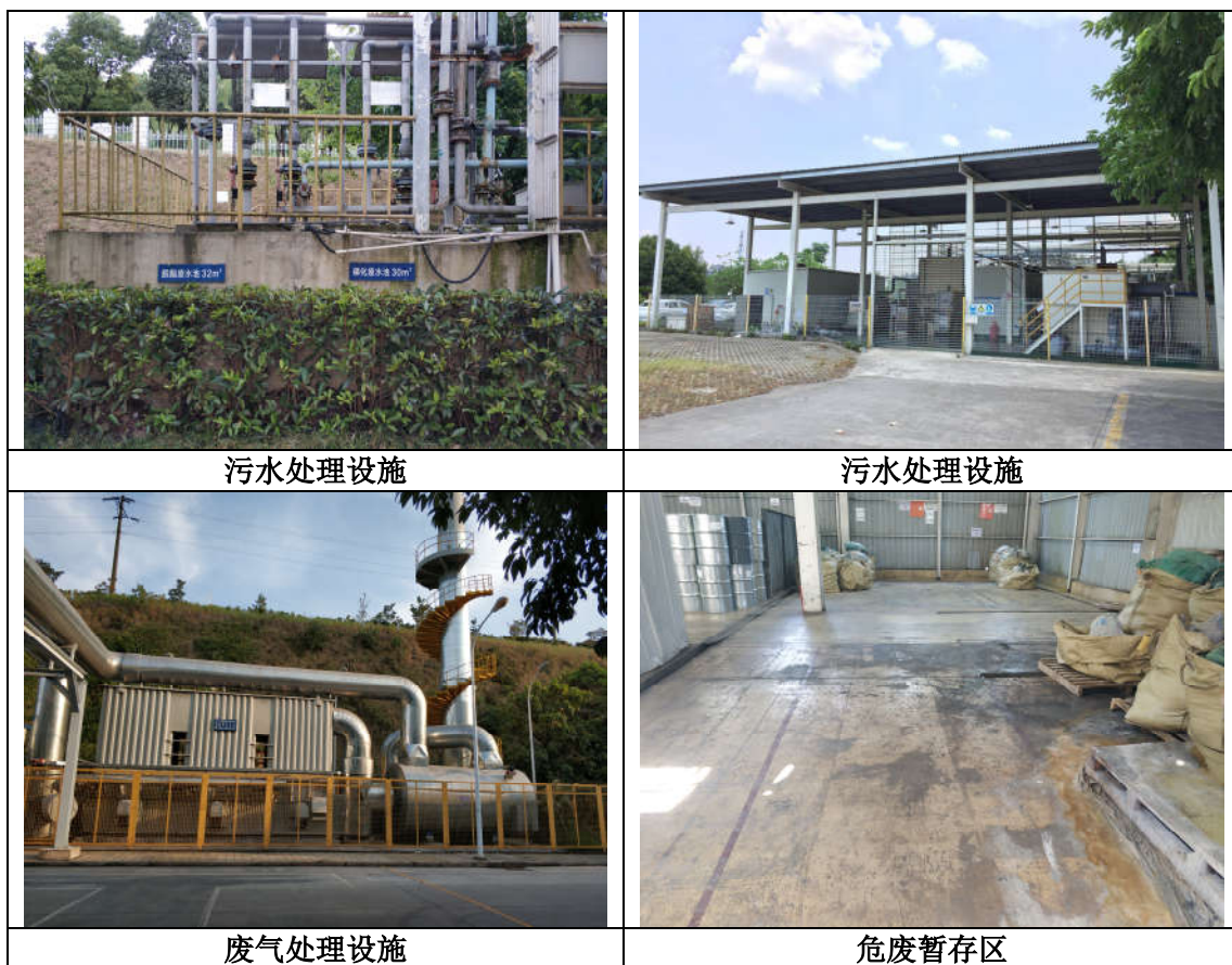
图 4-1 场地现状图及现场踏勘照片
